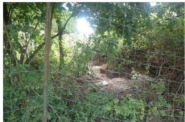
02.09.2023: Der Kanal inkl. Revisionsschacht befindet sich bereits in der Hecke.
